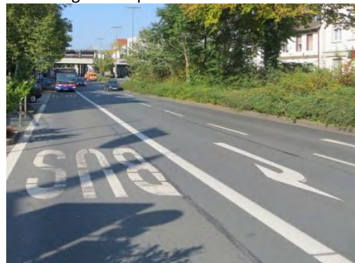
Abbildung 8: Busspur im Stadtzentrum Iserlohn
