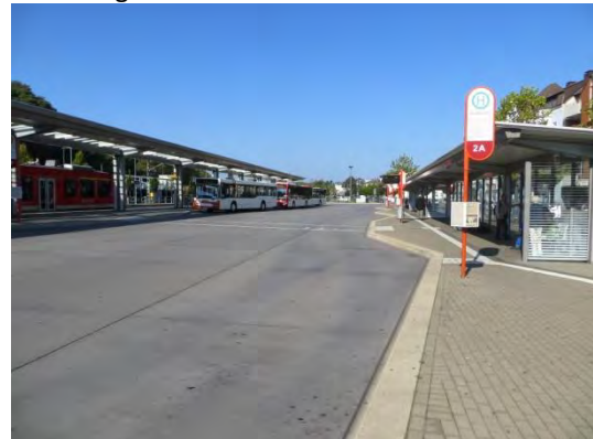
Abbildung 12: Modernisierter Stadtbhf. Iserlohn
