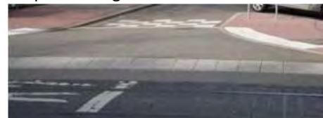
Abbildung 86: "Gehwegnase" mit Aufpflasterung
