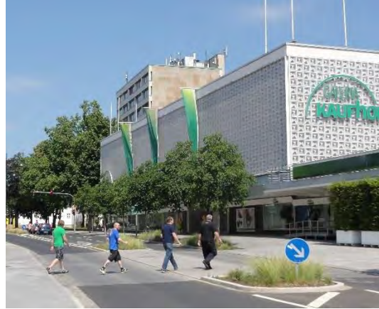
Abbildung 82: großzügige Mittelinsel in Schweinfurt mit Fahrbahnbelagswechsel
