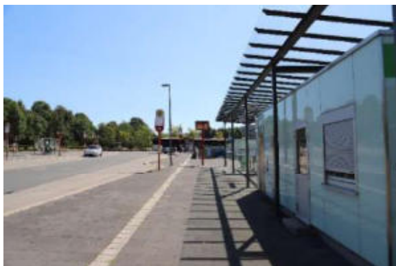
Abbildung 68 ZOB Wartebereich mit WC
