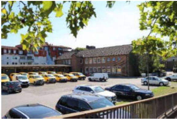
Abbildung 50 Rückansicht des Postgebäudes
