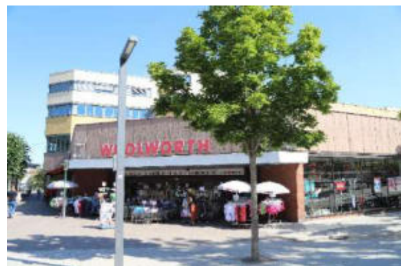
Abbildung 29 Geschäftskomplex am Neuen Markt
