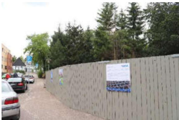
Abbildung 10 Bauplatz an der Steinert/Ecke Hauptstr.
