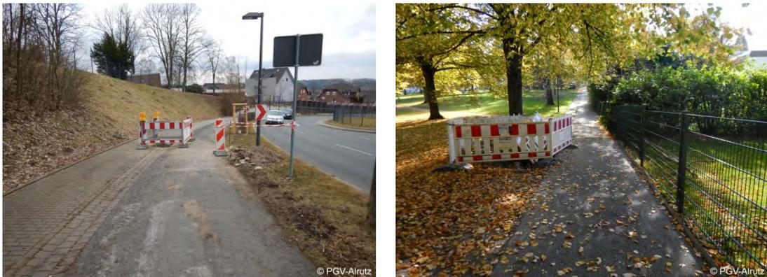
Abb. 5-25: Fehlende Berücksichtigung des Radverkehrs bei Baustellen im Zuge der Deilinghofer Straße (links) und der Wegeverbindung zwischen Parkstraße und Feldstraße (rechts)
