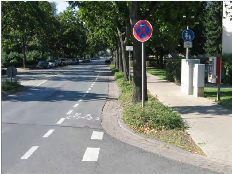
Abb. 5-11: Kombination von Schutzstreifen mit Gehweg, Radverkehr frei (Hameln)
