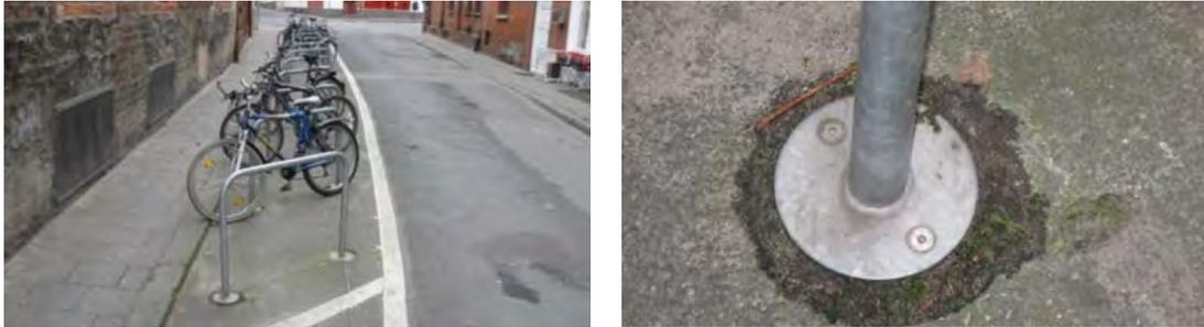
Abb. 6-4: Beispiele für verschraubte Rahmenhalter (Lüneburg)
