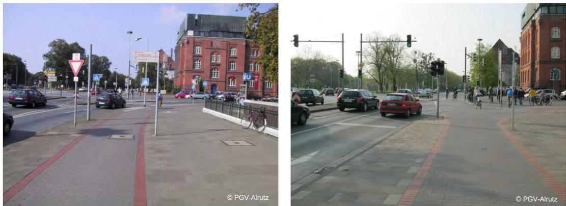
Abb. 5-18: Rückbau und Signalisierung eines konfliktträchtigen freien Rechtsabbiegefahrstreifens in Hannover (links vorher, rechts nachher)
