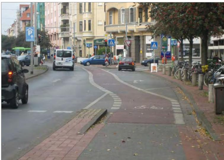
Abb. 5-16: Übergang Radweg in Radfahrstreifen an signalisiertem Knotenpunkt (Hannover)
