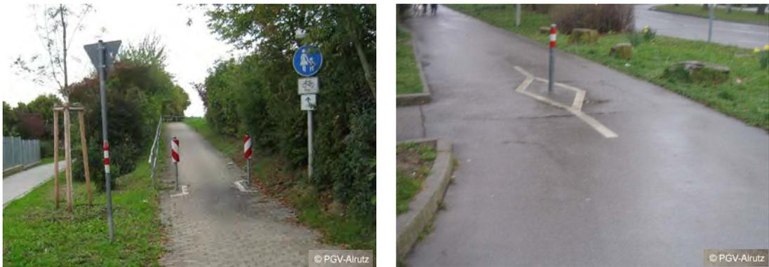
Abb. 5-24: Beispiele für beidseitige Poller mit Bodenmarkierungen in Bruchsal (links) und mittiger Poller mit Bodenmarkierung in Stuttgart (rechts)
